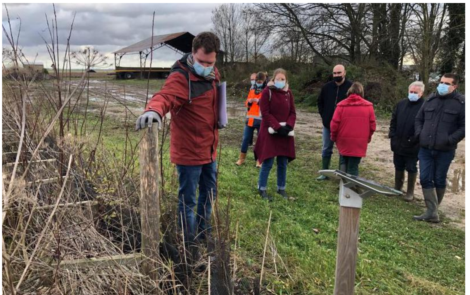
Valentin Deforest, chargé de projets au sein du syndicat des eaux local, a détaillé les travaux à des élus, responsables d'associations et riverains, ce mercredi.
