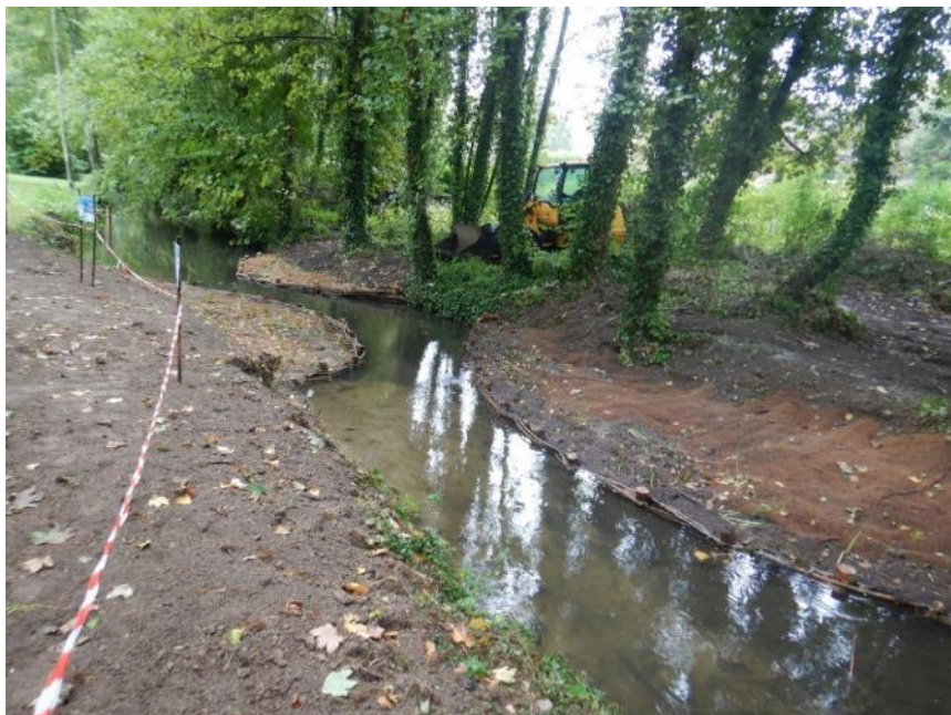
Photo des banquettes végétalisées mises en place par le SISN
